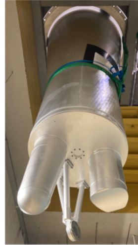
Avril et mai 2022 Mise en place du doigt de gant et de la cheminée
