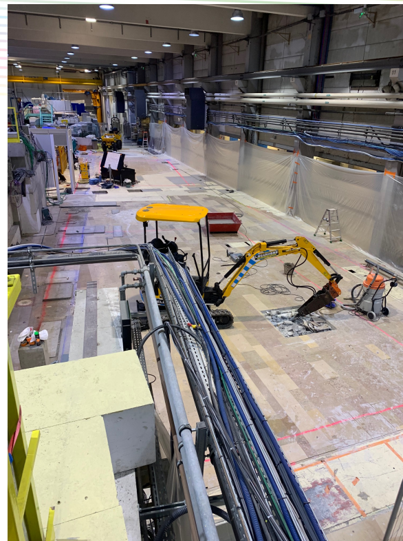
Travaux sur H24
